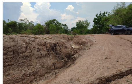
ภาพที่ 5-5 คันทำนบดินและคูระบายน้ำ
